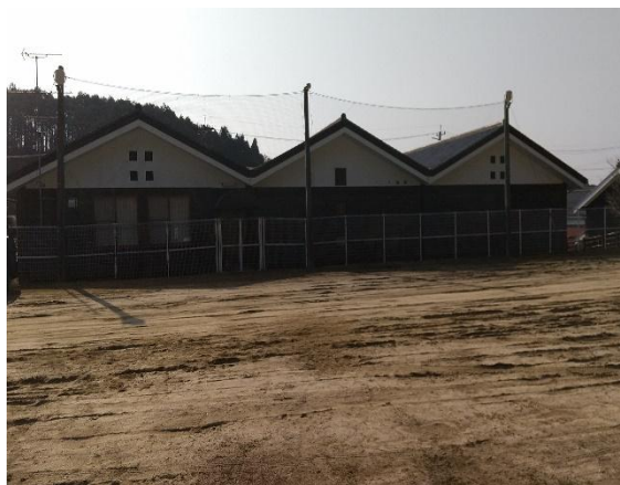
夜間照明の設置
