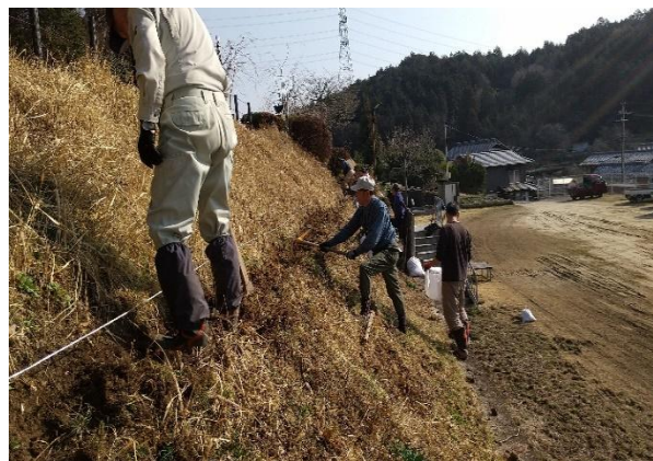
法面の安全管理用足場の設置
