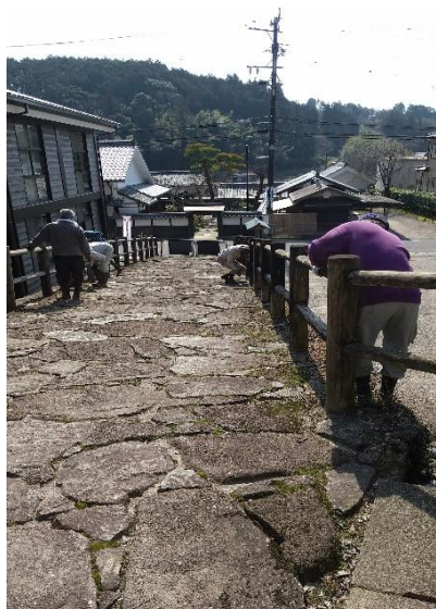
通路手すりの補修作業
