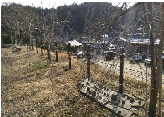
安全柵の設置
