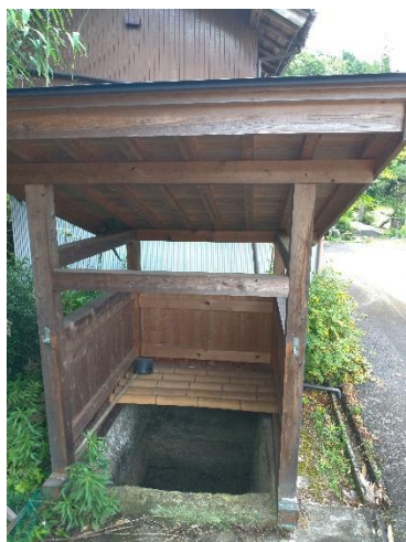
水枯れとなった天王さまの井戸
