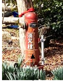
④ 地下式消火栓・地上式消火栓どちらも汚れた水を流してからホースを取り付けます。
