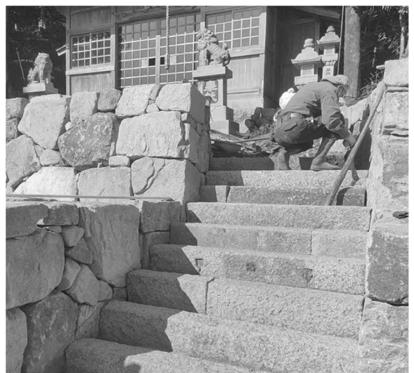
折れたり、外れたり不揃いな既存の階段石を加工しながら、整然とした雰囲気の階段を作る。 (写真上)
