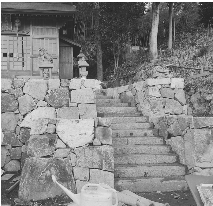
折れたり、外れたり不揃いな既存の階段石を加工しながら、整然とした雰囲気の階段を作る。 (写真上)
