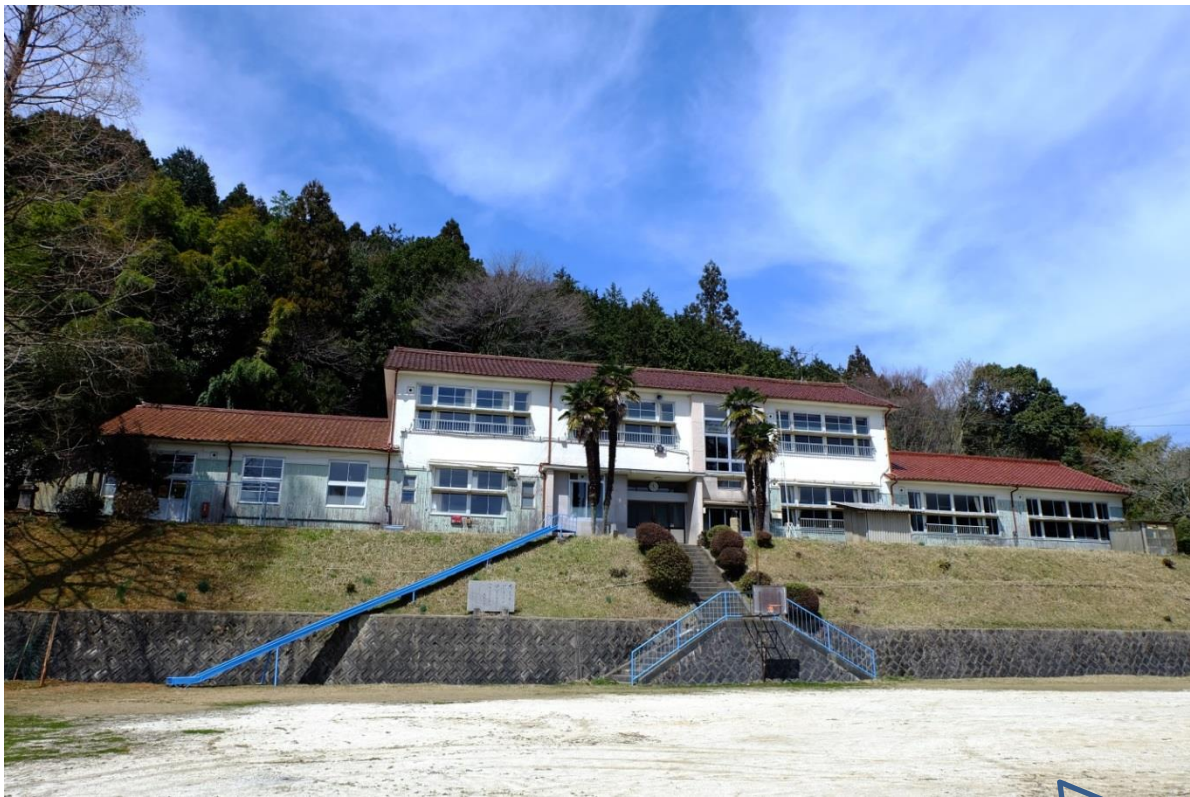
昭和33年5月設立～平成17年3月閉校 平成30年3月取り壊し
